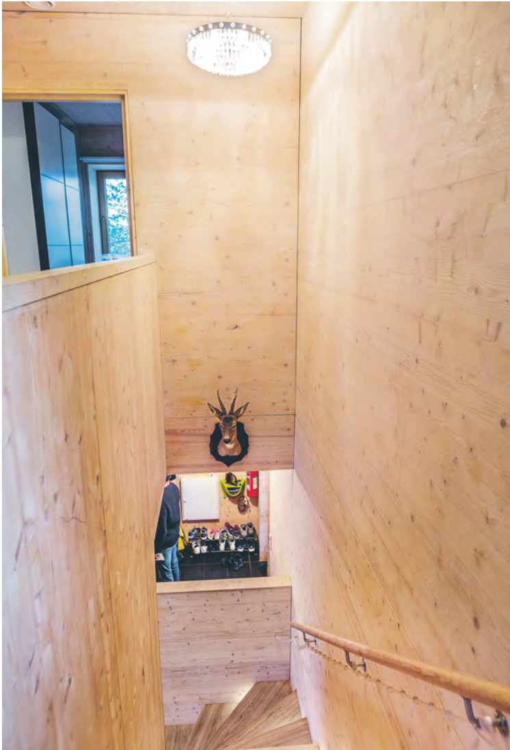
Om något är fel, till exempel om en värmepump får problem, så skruvar man bort en skiva och kommer åt problemet. Inget behöver rivras, allt kan repareras.
